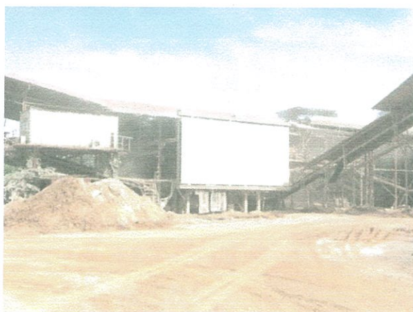
รูปที่ 14 การปิดคลุมอาคารโรงไม้หิน ชุด Secondary & Tertiary Crusher
