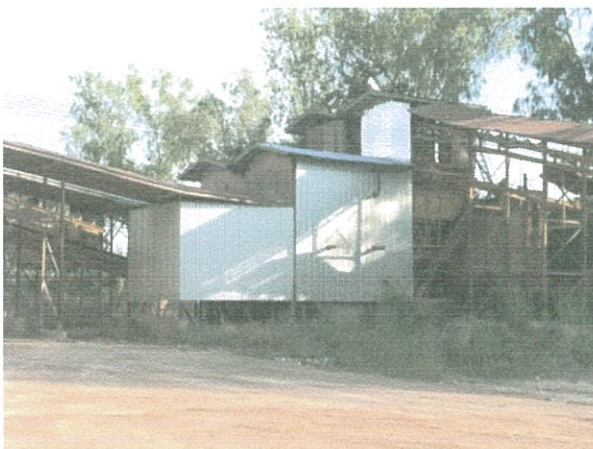
รูปที่ 15 การปิดคลุมอาคารโรงโม่หิน ชุด Hopper และ Primary Crusher
