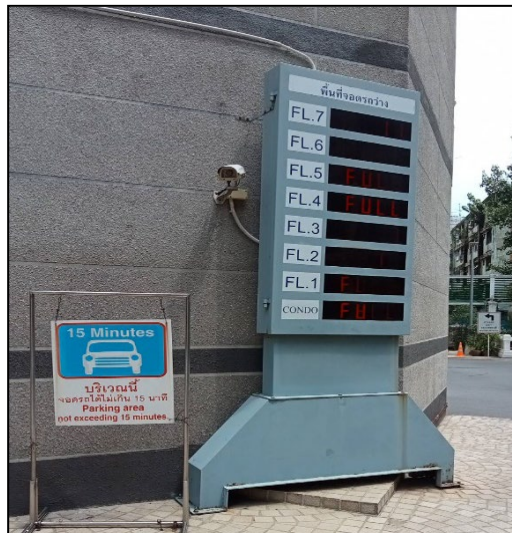
ภาพที่ 2-10 ระบบการตรวจนับช่องจอดรถในส่วนของ Plaza
