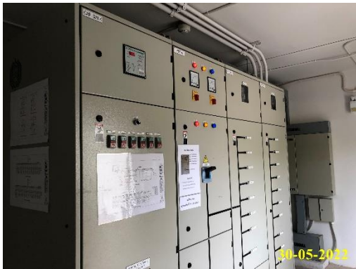
Main Distribution Board อาคาร A
