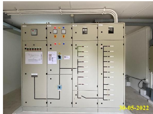
Main Distribution Board อาคาร B
