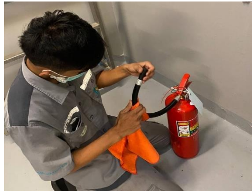
เจ้าหน้าที่ตรวจเช็ค และบำรุงรักษาอุปกรณ์ป้องกันและแจ้งเหตุเพลิงไหม้
