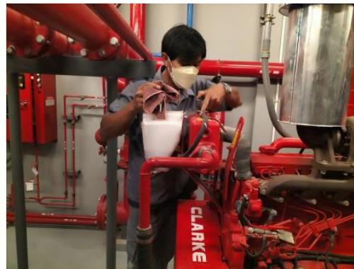
เจ้าหน้าที่ตรวจเช็ค และบำรุงรักษาเครื่องสูบน้ำดับเพลิง
