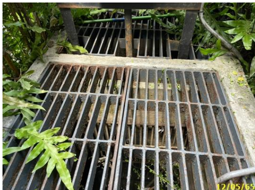
ตะแกรงดักขยะ ประตูระบายน้ำ พร้อมตู้ควบคุม
