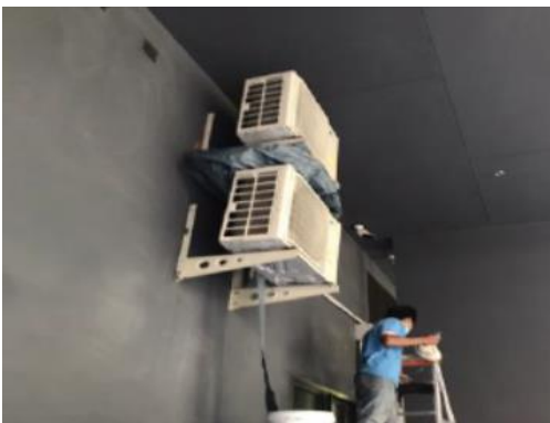
ล้างทำความสะอาดระบบปรับอากาศพื้นที่ส่วนกลาง
