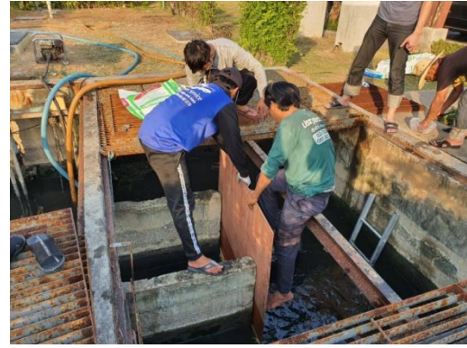
สูบลากตะกอนระบบบำบัดน้ำเสีย
