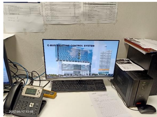
ระบบควบคุมเปิดปิดไฟส่วนกลาง
