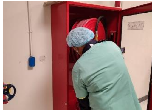
ทดสอบสายถังดับเพลิง ในตู้ FHC
