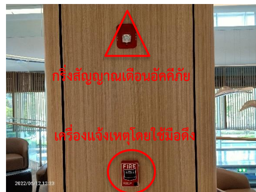
เครื่องแจ้งเหตุโดยไข่มือดึง (Fire Alarm Manual Station) และกริ่งสัญญาณเตือนอัคคีภัย (Alarm Horn)
