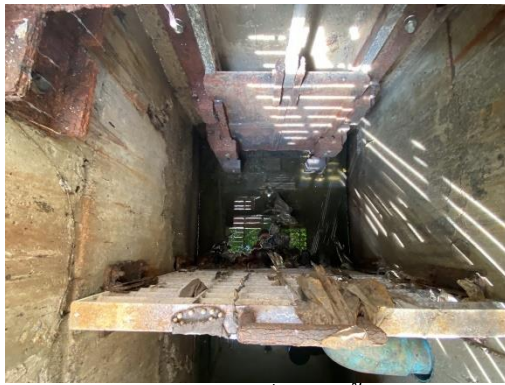
ตะแกรงดักมูลฝอยที่บ่อพักน้ำสุดท้าย
