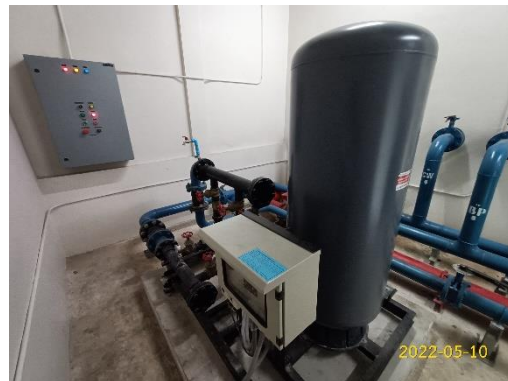
เครื่องสูบน้ำเสริมแรงดันชั้นดาดฟ้า
