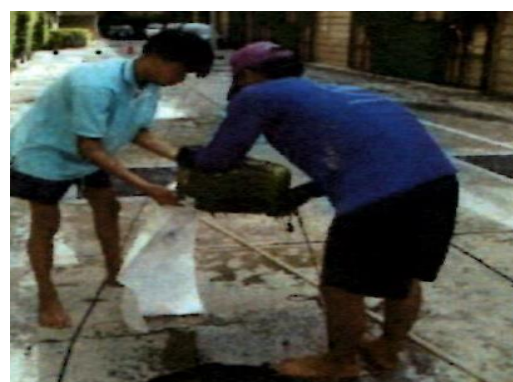
สับตะกอนและไขมัน
