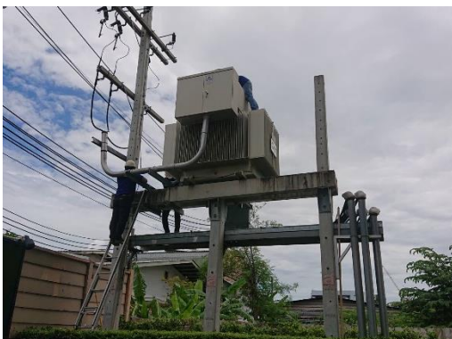
เจ้าหน้าที่ตรวจสอบการทำงานของหม้อแปลงไฟ
