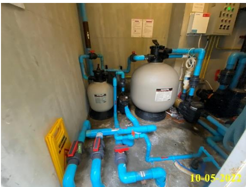
ระบบกรองและฆ่าเชื้อสระว่ายน้ำ
