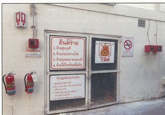
รูปที่ 2.2-3 อุปกรณ์ดับเพลิง
