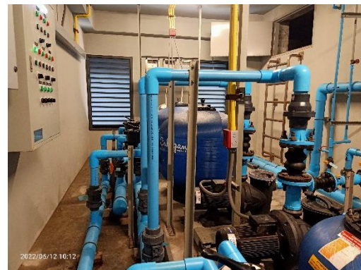
ห้องเครื่องปั๊มน้ำ ระบบกรองน้ำ และระบบเติมเกลือ ของสระว่ายน้ำ
