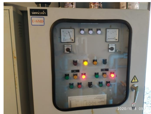
ตู้ควบคุมปั๊มสูบน้ำของบ่อหน่วยน้ำ
