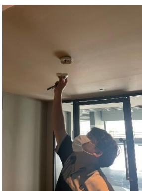
ตรวจสอบเครื่องตรวจจับควัน
