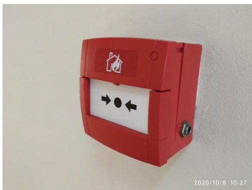
เครื่องแจ้งเหตุโดยใช่มือดึง และช่องเสียบโทรศัพท์ ฉุกเฉิน
