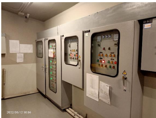
ตู้ควบคุมระบบบำบัดน้ำเสียแห่งที่ 1
