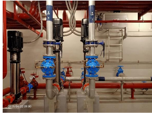
ปั๊มสูบน้ำไปเก็บที่ชั้นดาดฟ้า
