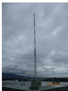
ภาพที่ 2.41 ระบบป้องกันฟ้าผ่าแบบสายล่อฟ้า
