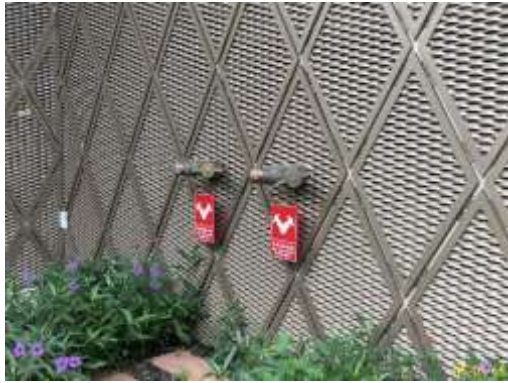
หัวรับน้ำดับเพลิง ระบบป้องกันเพลิงไหม้ (ต่อ)
