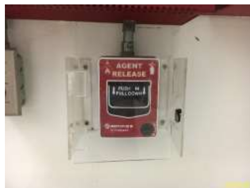
ปุ่มกดแจ้งสัญญาณอัคคีภัย และอุปกรณ์ส่งเสียงสัญญาณแจ้งเหตุ
