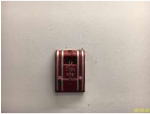
ปุ่มกดแจ้งสัญญาณอัคคีภัย และอุปกรณ์ส่งเสียงสัญญาณแจ้งเหตุ ระบบตรวจสอบและแจ้งเหตุเพลิงไหม้
