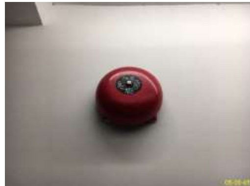
ปุ่มกดแจ้งสัญญาณอัคคีภัย และอุปกรณ์ส่งเสียงสัญญาณแจ้งเหตุ
