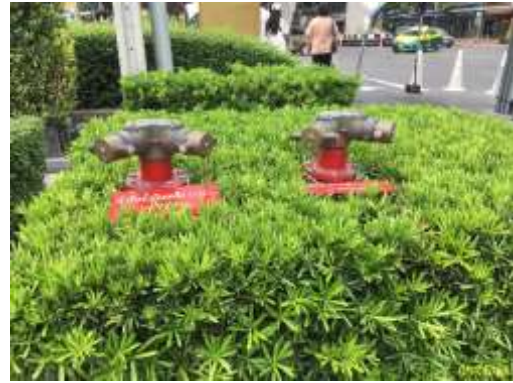
หัวรับน้ำดับเพลิง ระบบป้องกันเพลิงไหม้ (ต่อ)
