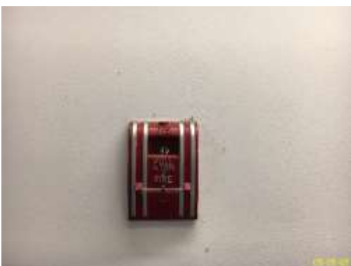
ปุ่มกดแจ้งสัญญาณอัคคีภัย และอุปกรณ์ส่งเสียงสัญญาณแจ้งเหตุ
