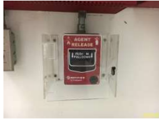
ปุ่มกดแจ้งสัญญาณอัคคีภัย และอุปกรณ์ส่งเสียงสัญญาณแจ้งเหตุ ระบบตรวจสอบและแจ้งเหตุเพลิงไหม้
