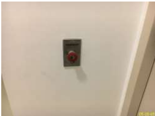
ปุ่มกดแจ้งสัญญาณอัคคีภัย และอุปกรณ์ส่งเสียงสัญญาณแจ้งเหตุ
