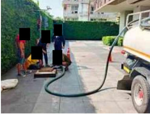
การสูบน้ำก่อนระบบบำบัด
