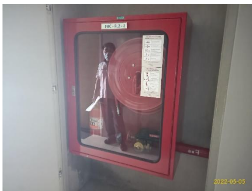
ตู้เก็บสายฉีดยาน้ำดับเพลิงพร้อมอุปกรณ์
