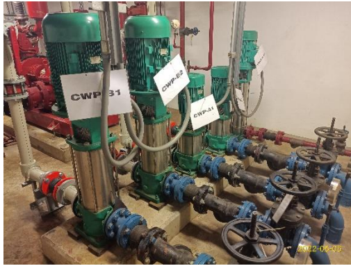
เครื่องสูบน้ำในระบบประปา
