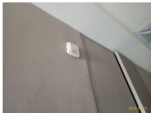
อุปกรณ์ส่งสัญญาณเหตุฉุกเฉิน
