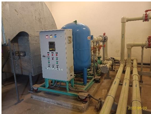
เครื่องสูบน้ำรักษาแรงดันอาคาร A
