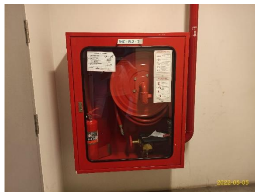
ตู้เก็บสายฉีดยาน้ำดับเพลิงพร้อมอุปกรณ์
