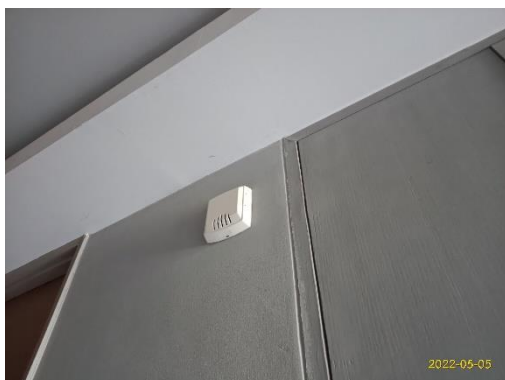
อุปกรณ์ส่งสัญญาณเหตุฉุกเฉิน
