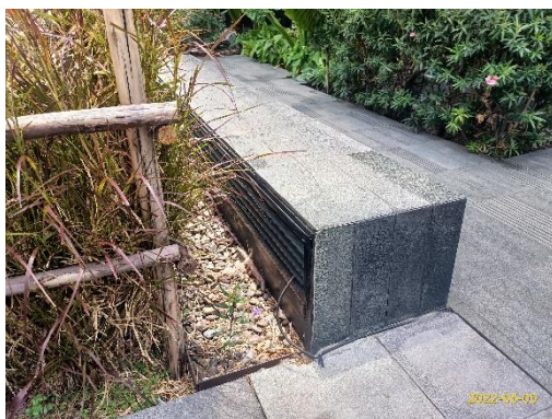
ช่องดูดอากาศชั้นจอดรถใต้ดิน
