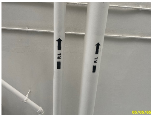
ระบบระบายน้ำฝนจากหลังคาอาคาร
