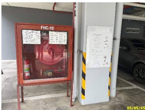
ระบบท่อเย็นและตู้เก็บสายน้ำดับเพลิง พร้อมอุปกรณ์
