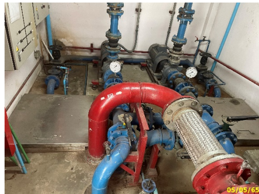
เครื่องสูบน้ำดับเพลิง (Fire Pump) และเครื่องสูบน้ำช่วยดับเพลิง (Jokey Pump)
