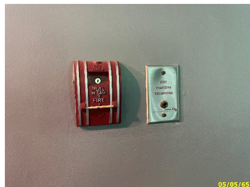
เครื่องแจ้งเหตุโดยใช้อัตโนมัติ (Fire Alarm Manual Station)
