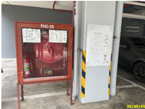
ระบบท่อเย็นและตู้เก็บสายน้ำดับเพลิง พร้อมอุปกรณ์
