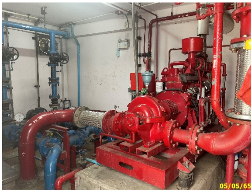
เครื่องสูบน้ำดับเพลิง (Fire Pump) และเครื่องสูบน้ำช่วยดับเพลิง (Jokey Pump)
