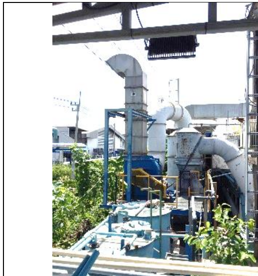
รูปที่ 2-6 ระบบบำบัดมลพิษทางอากาศปล่อง Buff
