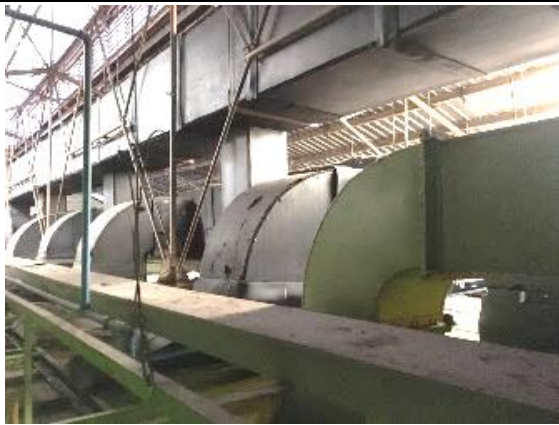
รูปที่ 2-7 ภาพถ่ายระบบรวบรวมอากาศภายในอาคาร Painting
