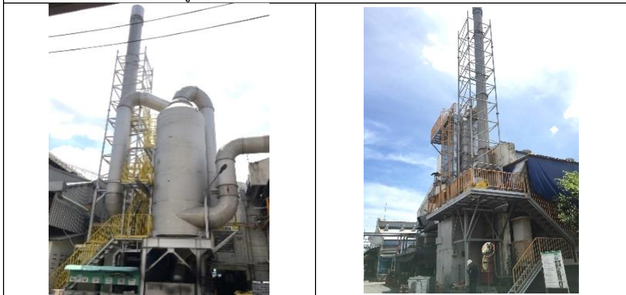
รูปที่ 2-2 ระบบบำบัดมลพิษทางอากาศอาคาร DC2
