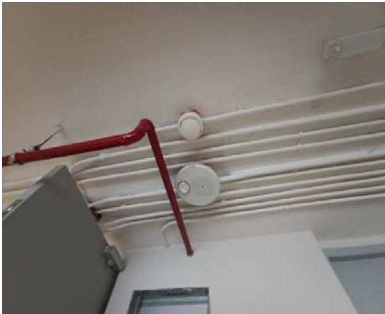
รูปที่ 2-29 อุปกรณ์ป้องกันอัคคีภัยและอุปกรณ์ดับเพลิง (Fire Protection and Fire Equipment)
