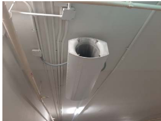
รูปที่ 2-8 ระบบระบายอากาศบริเวณที่จอดรถ
