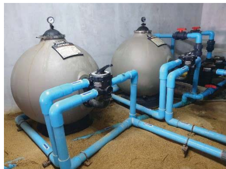
ภาพที่ 2.2-13 ระบบกรองของสระว่ายน้ำ
