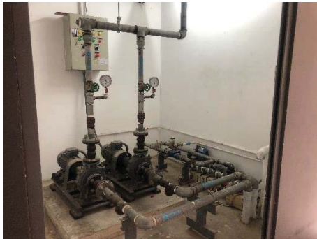
ภาพที่ 2.2-10 ระบบสูบน้ำประปาและวาล์วควบคุมการจ่ายน้ำ
