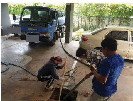
ภาพที่ 2.2-8 การทำความสะอาดบ่อดักไขมันและการสูบล้างถัง
