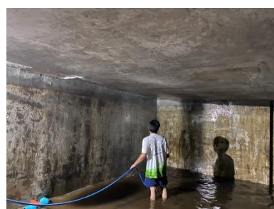
ภาพที่ 2-18 (ต่อ) การทำความสะอาดถังเก็บน้ำใต้ดินและตรวจสอบการรั่วไหล
