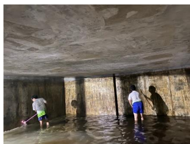
ภาพที่ 2-18 การทำความสะอาดถังเก็บน้ำใต้ดินและ ตรวจสอบการรั่วไหล
