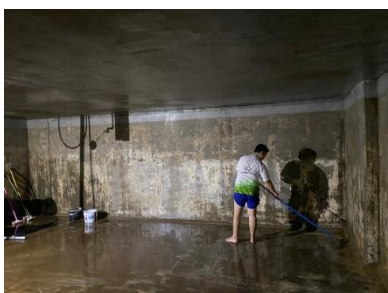
ภาพที่ 2-18 (ต่อ) การทำความสะอาดถังเก็บน้ำใต้ดินและตรวจสอบการรั่วไหล
