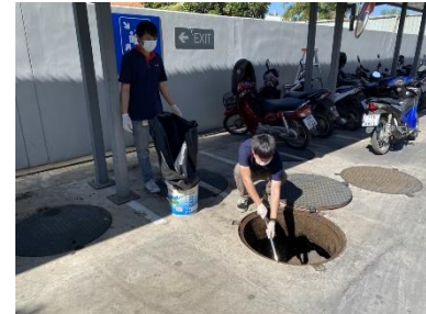
ภาพที่ 2-27 การทำความสะอาดบ่อดักตะกอน
