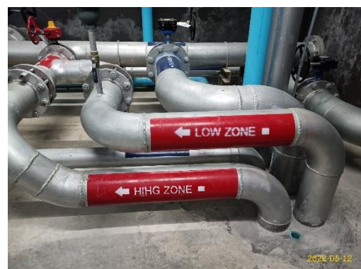
ระบบท่อน้ำดับเพลิงหรือท่อยื่น
