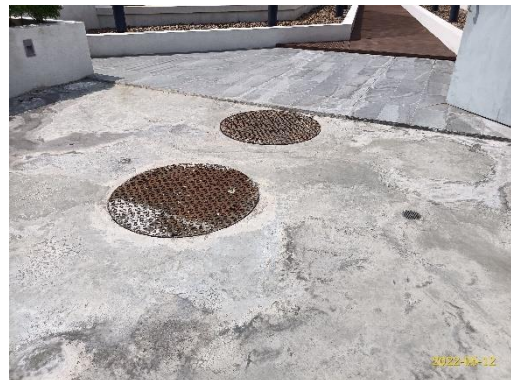
ฝาท่อถังเก็บน้ำชั้นดาดฟ้า
