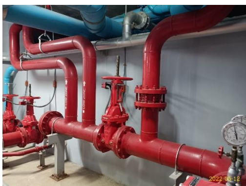
ระบบท่อน้ำดับเพลิงหรือท่อยื่น
