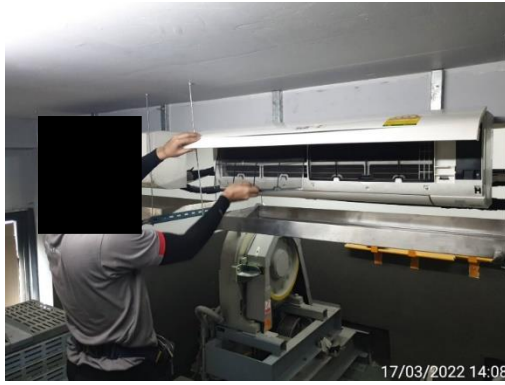
การทำความสะอาดเครื่องปรับอากาศส่วนกลาง
