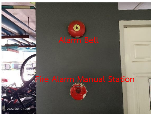
Fire Alarm Manual Station และ Alarm Bell
