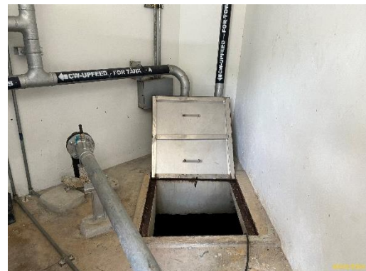
ถังเก็บน้ำใต้ดินและระบบกรองน้ำ
