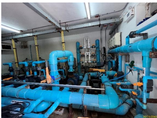
ระบบปั๊มและกรองสระว่ายน้ำ
