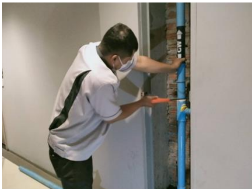
ซ่อมบำรุงท่อระบบส่งน้ำใช้
