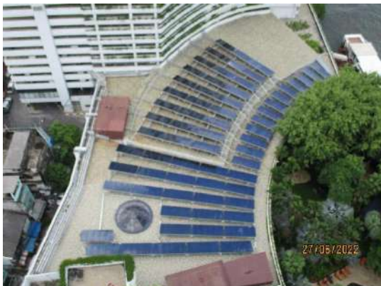
(1) เครื่องทำน้ำร้อนพลังแสงอาทิตย์ (Solar Collector)
