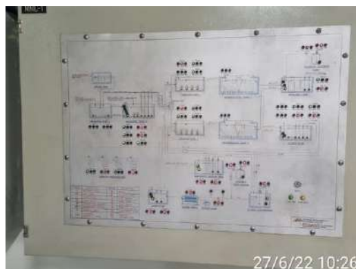
(10) แผนผังแสดงการทำงานของระบบบำบัด
