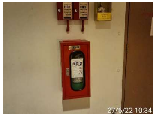
(8) เครื่องแจ้งเหตุโดยใช้มือดึง (Fire Alarm Manual Station)
