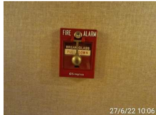
(8) เครื่องแจ้งเหตุโดยใช้มือดึง (Fire Alarm Manual Station)
