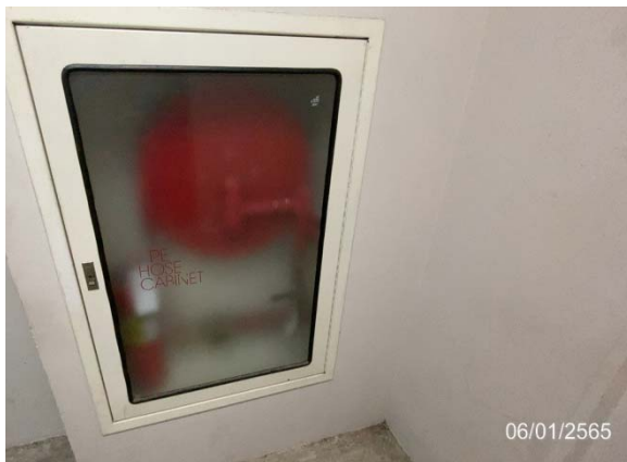
ตู้สายฉีดน้ำดับเพลิง ภายในอาคาร (Fire Hose Cabinet : FHC)
