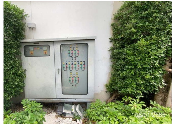
รูปที่ 2-14 ระบบมิเตอร์ไฟฟ้าของระบบบำบัดน้ำเสีย
