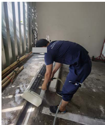
รูปที่ 2-34 เจ้าหน้าที่ทำความสะอาดเครื่องปรับอากาศ
