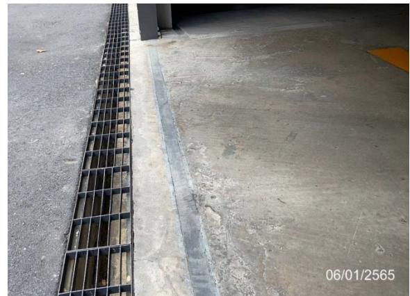
รูปที่ 2-50 ตะแกรงครอบบริเวณรางระบายน้ำ
