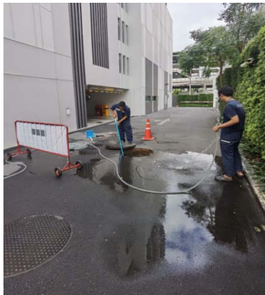
รูปที่ 2-13 การสูบน้ำออกจากระบบบำบัดน้ำเสีย
