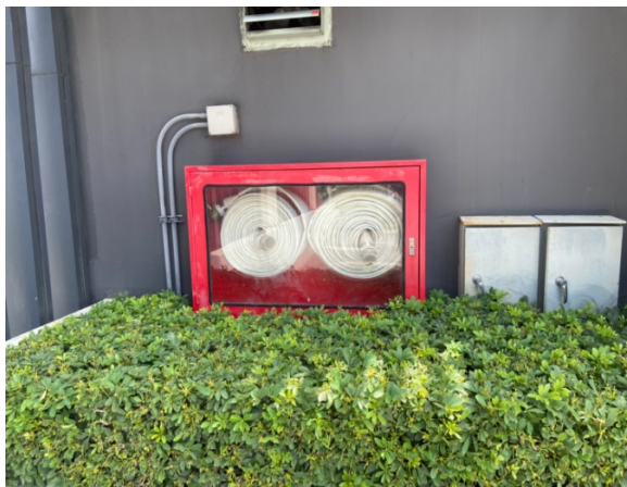
ตู้สายฉีดน้ำดับเพลิง นอกอาคาร (Fire Hose Cabinet : FHC)
