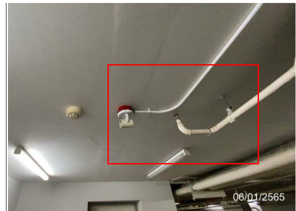
หัวกระจายน้ำดับเพลิงแบบอัตโนมัติ (Spinker)
