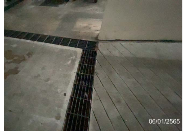
รูปที่ 2-22 รางระบายน้ำของชั้นใต้ดิน
