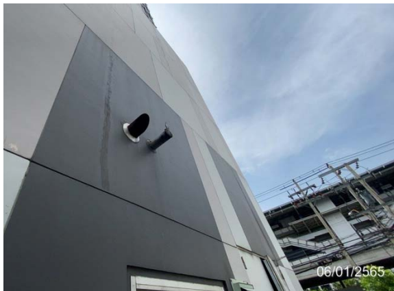
รูปที่ 2-32 ปล่องระบายอากาศไอเสีย จากห้องเครื่องกำเนิดไฟฟ้า
