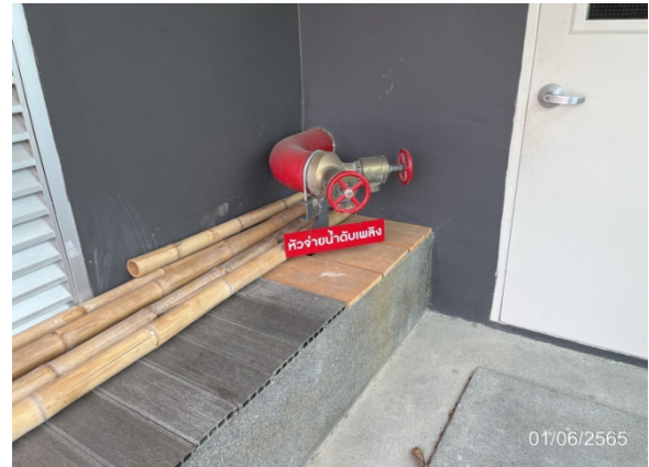
หัวรับน้ำดับเพลิง (Fire Department Connector : FDC)
