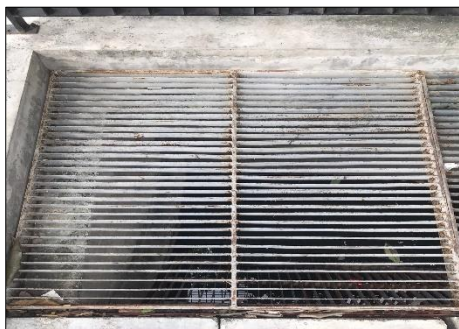
ภาพที่ 34 ตะแกรงดักขยะที่ Man Hole(ต่อ)
