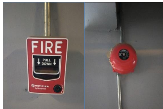
ภาพที่ 19 Alarm Bell, Manual Station
