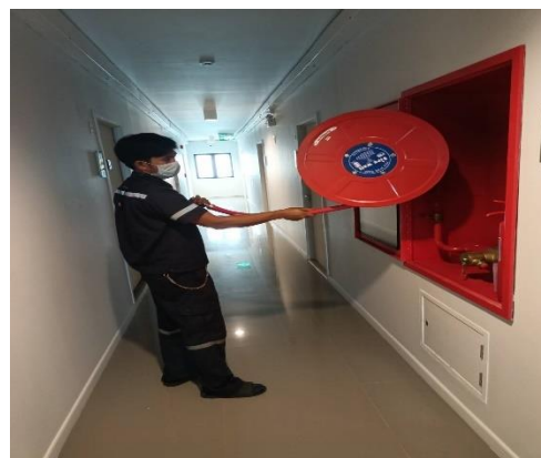
ภาพที่ 21 ระบบท่อขึ้นสำหรับระบบป้องกันอัคคีภัย
