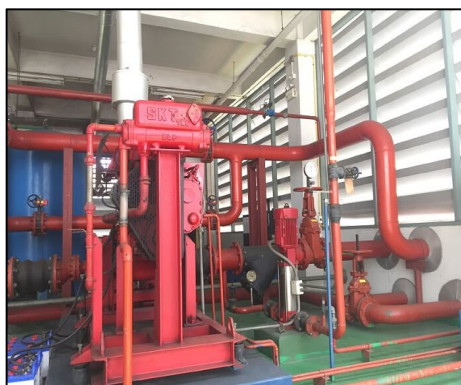
ภาพที่ 3.48 เครื่องสูบน้ำดับเพลิง
