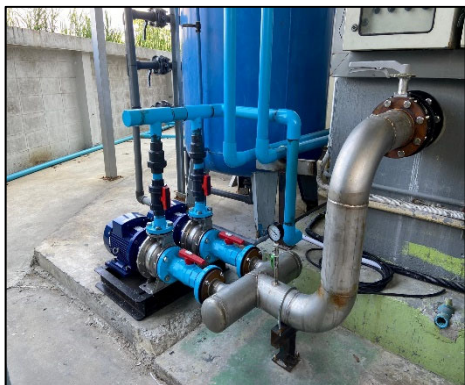
ภาพที่ 3.13 อุปกรณ์สำรองของระบบบำบัดน้ำเสีย
