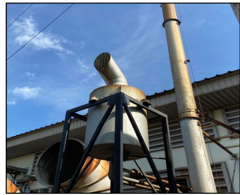
ภาพที่ 3.6 ตัวเก็บเสียง (Silencer) ที่วาล์วควบคุมความ ดันเกิน (Safety Release Valve)
