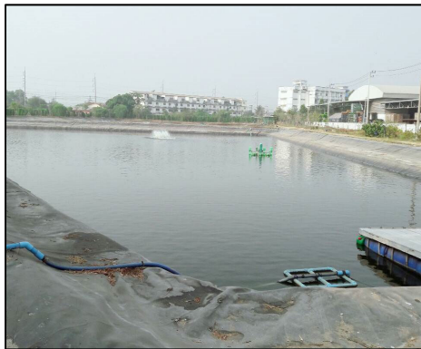
ภาพที่ 3.23 บ่อพักน้ำทิ้งที่มี Freeboard ไม่น้อยกว่า 0.5 เมตร
