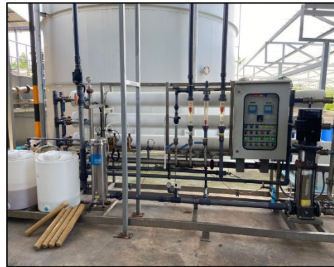
ภาพที่ 3.14 ระบบปรับปรุงคุณภาพน้ำทิ้งแบบอาร์โอ
