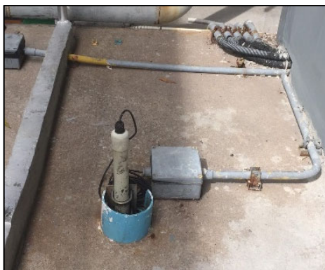
ภาพที่ 3.16 อุปกรณ์ตรวจวัดคุณภาพน้ำแบบอัตโนมัติ (ตรวจวัดพีเอช และค่าการนำไฟฟ้า)
