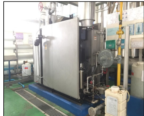
ภาพที่ 3.8 การติดตั้งอุปกรณ์/เครื่องจักร ของหม้อไอน้ำภายในอาคาร
