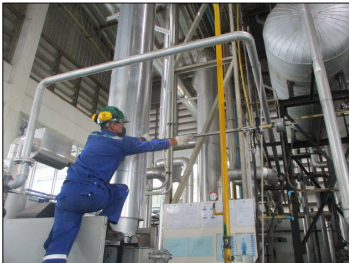
ปล่องหม้อน้ำใช้ก๊าซแอลพีจีเป็นเชื้อเพลิง (ชุดที่ 2 )
