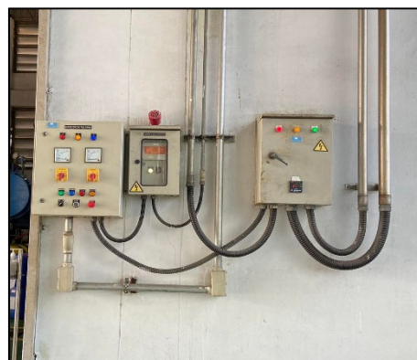
ภาพที่ 3.49 ระบบ Gas Detector บริเวณพื้นที่จัดวางถังก๊าซแอลพีจี
