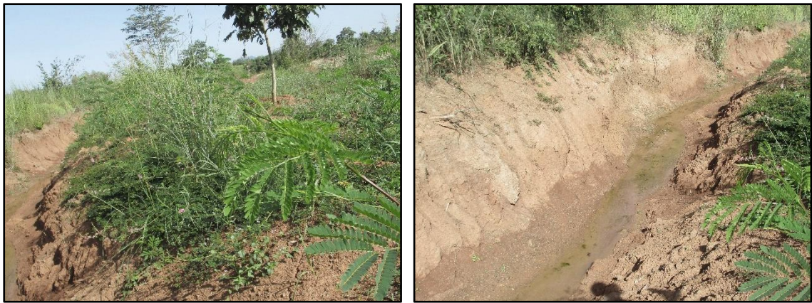
ภาพที่ 3.33 คันดินและคูระบายน้ำพื้นที่โครงการ
