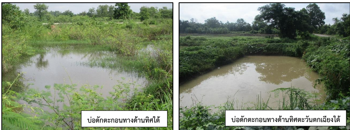
ภาพที่ 3.34 บ่อดักตะกอนของโครงการ
