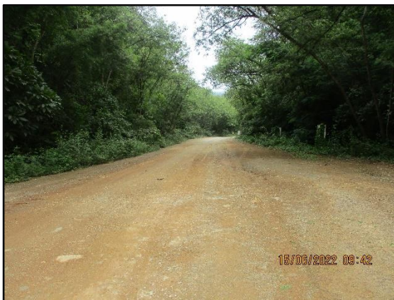
ภาพที่ 2.13 สภาพเส้นทางการลำเลียงแร่ที่ ปรับแต่งผิวถนนและบดอัดแน่น
