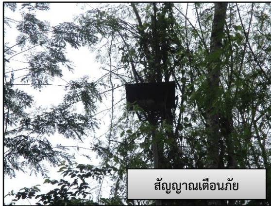
ภาพที่ 2.25 สัญญาณและ Siren เตือนภัยการระเบิด
