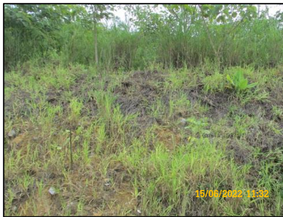
ภาพที่ 2.34 การปลูกหญ้าแฝกเพื่อป้องกันการพังทลายของหน้าดิน
