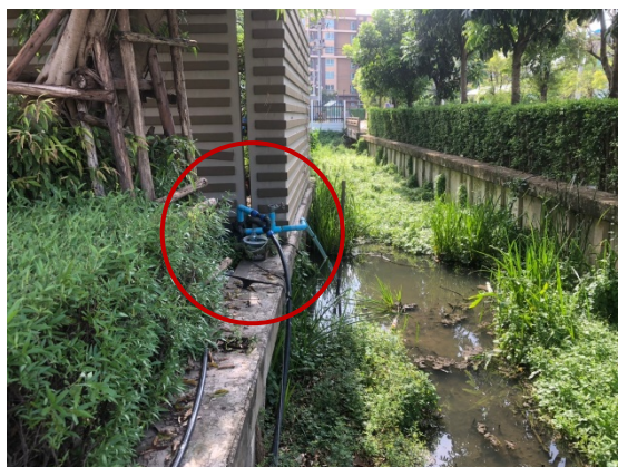
รูปที่ 8 ท่อสูบน้ำทิ้งที่ผ่านระบบบำบัดน้ำเสีย
