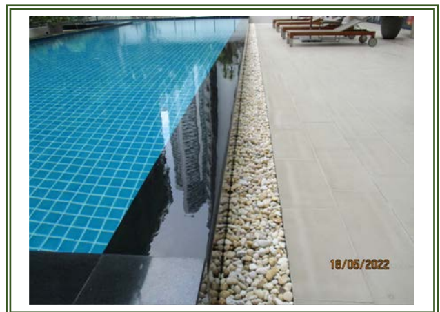
รูปที่ 2-46 รางระบายน้ำล้อมรอบสระว่ายน้ำ
