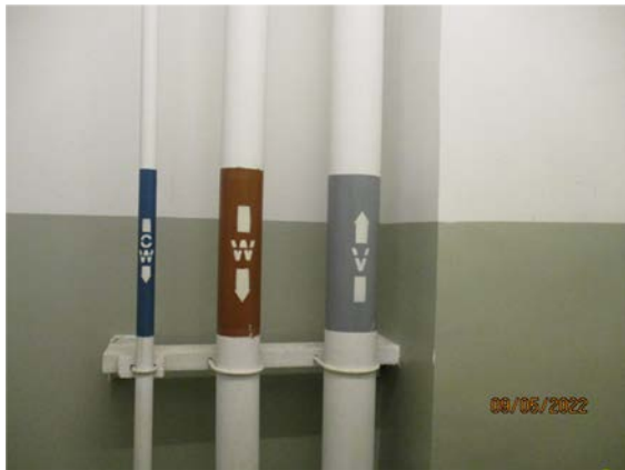
รูปที่ 2-27 ท่อรวบรวมน้ำเสียจากห้องพัสดุฝอย
