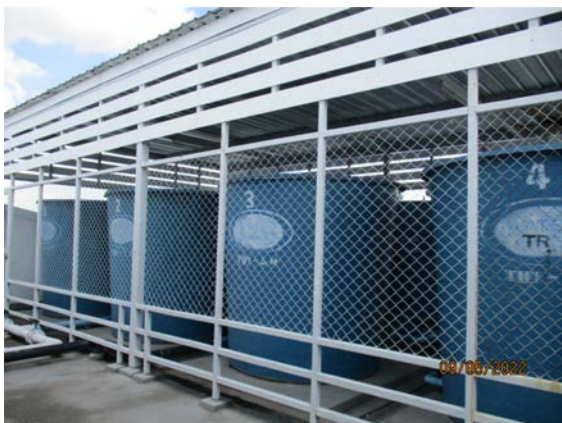
รูปที่ 2-13 ถังสำรองน้ำใต้ดิน และถังสำรองน้ำชั้นดาดฟ้า
