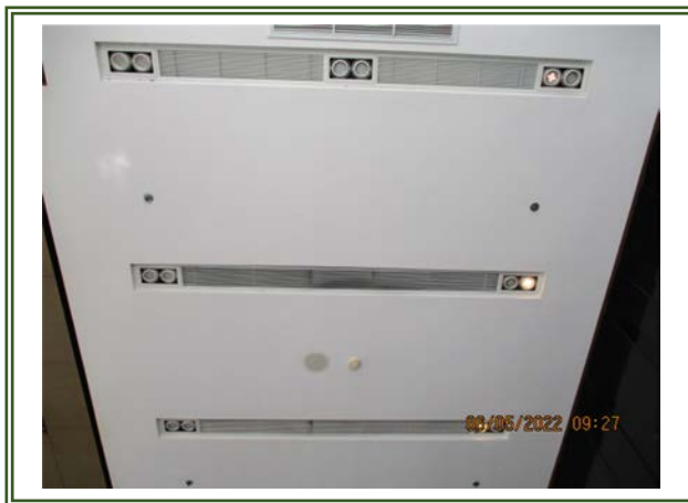
รูปที่ 2-22 หลอดไฟประหยัดพลังงาน พร้อมแผ่นสะท้อนกระจายแสง
