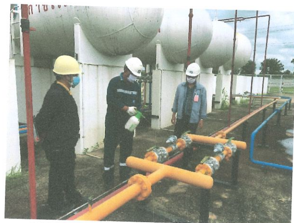
รูปที่ 7, 8 ภาพแสดงการตรวจสอบการหารอยรั่วซึมของระบบท่อ
