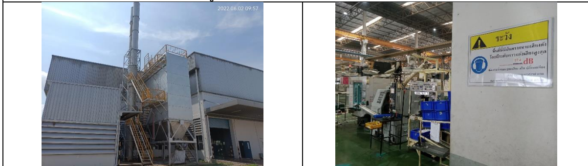
รูปที่ 2-20 ระบบดักฝุ่นแบบถุงกรอง
