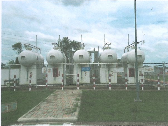
รูปที่ 1 ภาพแสดงสภาพโดยทั่วไปของถังเก็บและ จ่ายก๊าซปิโตรเลียมเหลวชนิดติดตั้งบนพื้นดิน
