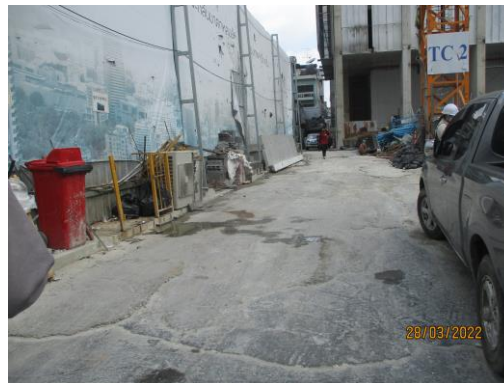
รั้ว Metal Sheet รอบพื้นที่โครงการ ความสูง 6 เมตร
