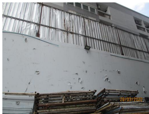
รั้ว Metal Sheet ด้านบริเวณ S.K. Apartment บ้านเลขที่ 159 ความสูง 9 เมตร
