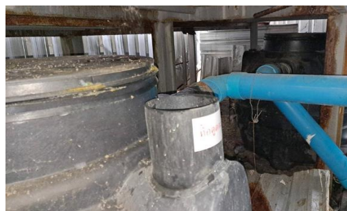
รูปที่ 29 ถังบำบัดน้ำเสียสำเร็จรูป
