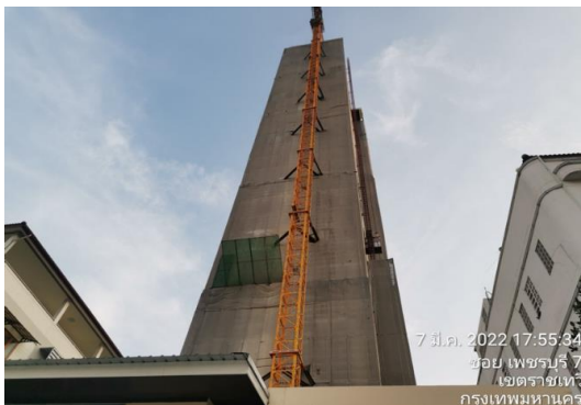
รูปที่ 53 การติดตั้ง Chain Link ของโครงการ
