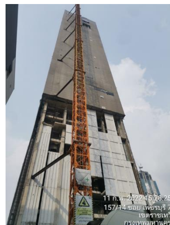
รูปที่ 15 การติดตั้ง Mesh Sheet โดยรอบโครงสร้างอาคาร
