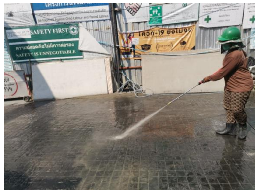
รูปที่ 13 การฉีดพรมน้ำภายในพื้นที่โครงการ
