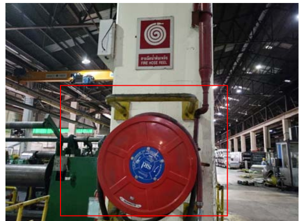
สายฉีดน้ำดับเพลิงภายในโรงงาน
