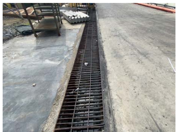
รางระบายน้ำภายในพื้นที่โครงการ
