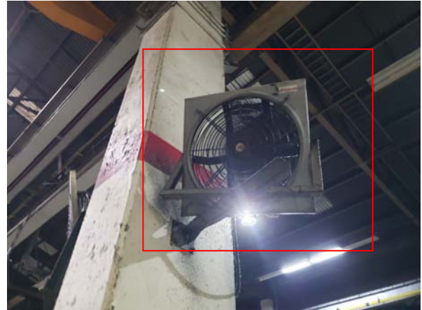
ระบบระบายอากาศบริเวณพื้นที่วาง Coil ร้อน
