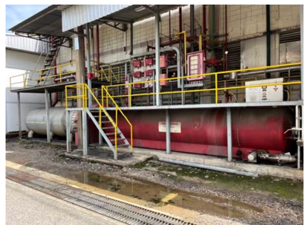
ถังดับเพลิงชนิด CO 2 ขนาด 10 ตัน บริเวณเครื่องรีดเย็น ชุดที่ 2
