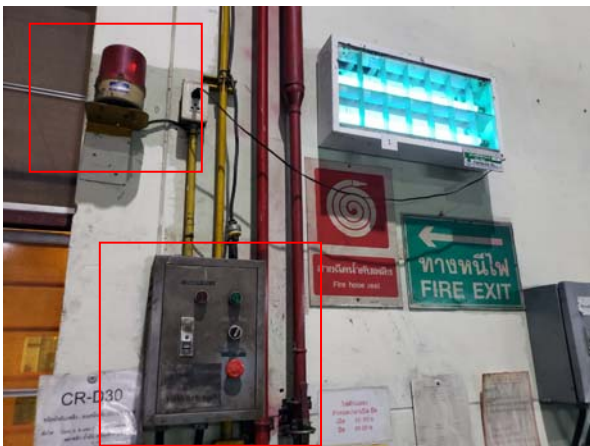
สัญญาณเตือนและสวิตช์ควบคุมเมื่อเกิดเหตุฉุกเฉิน
