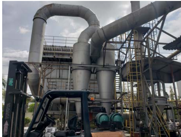
ระบบดักฝุ่นแบบถุงกรอง (Bag Filter)
