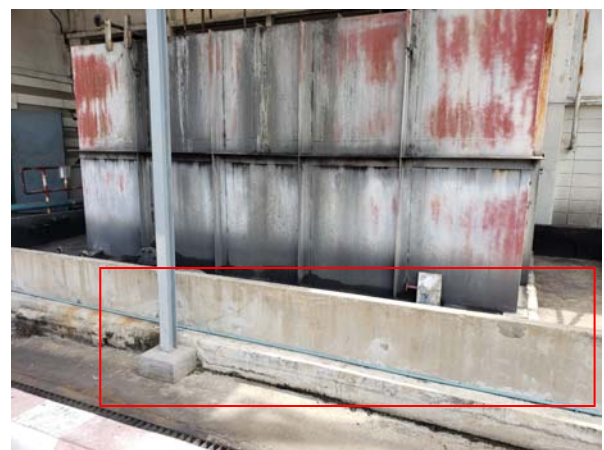
Dike Wall เพื่อรวบรวมน้ำมันใช้แล้ว ป้องกันกรณีเกิดการหกรั่วไหล
