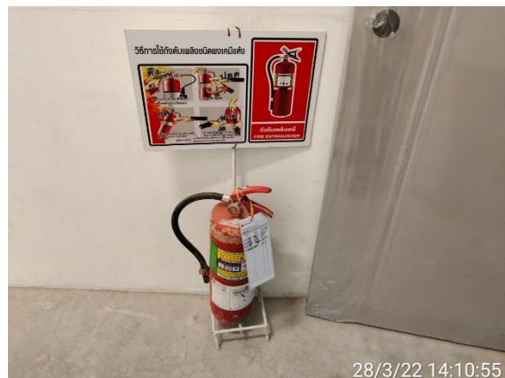
รูปที่ 34 ถังดับเพลิงและคู่มือการใช้งาน
