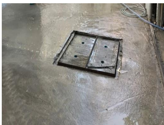
รูปที่ 27 บ่อรวบรวมน้ำก่อนระบาย ออกนอกโครงการ
