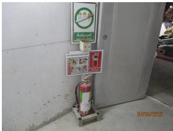
รูปที่ 34 ถังดับเพลิงและคู่มือการใช้งาน
