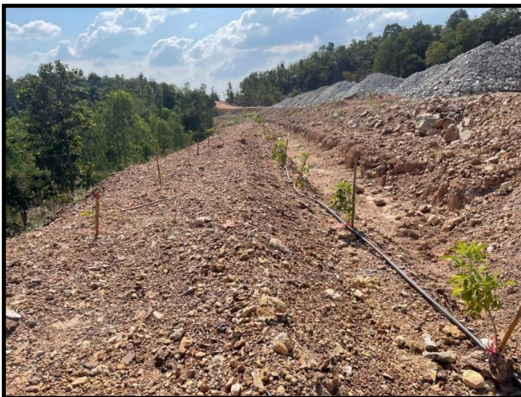
รูปที่ 21 สร้างคันทำนบดิน เพื่อบังคับให้น้ำไหลผ่านบ่อดักตะกอน (23 มีนาคม 2565)
