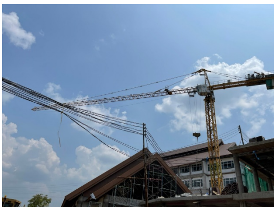
รูปที่ 28 การกวาดแขนเครนในพื้นที่ก่อสร้าง
