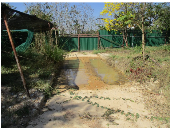
รูปที่ 16 บ่อล้างล้อรถบรรทุก
