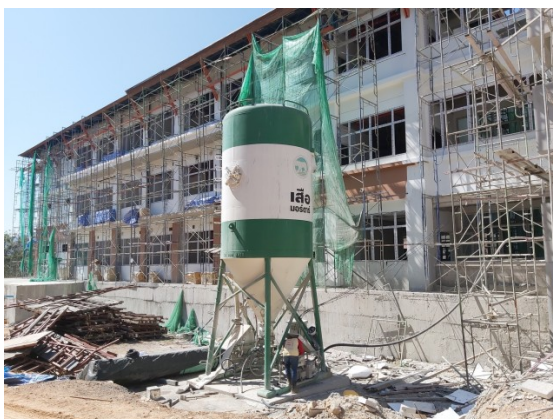
รูปที่ 15 ปูนซีเมนต์แบบสำเร็จรูปในงานก่อสร้าง
