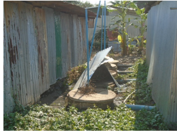
ถังบำบัดน้ำเสียแบบบ่อเกรอะ-บ่อซึม
