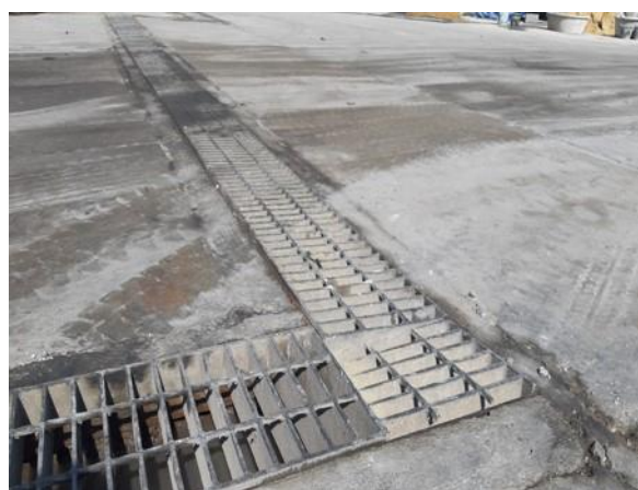
รูปที่ 8 ระบบระบายน้ำเสียของโรงงาน
