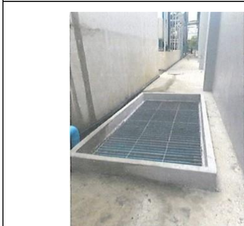
รูปที่ 5 ระบบท่อรวบรวมน้ำเสียของโรงงาน
