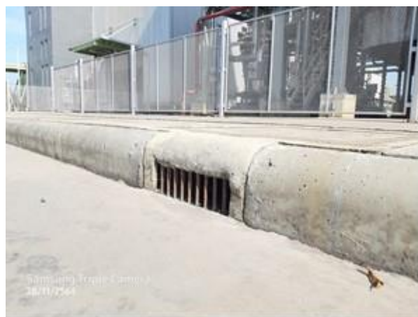
รูปที่ 6 ระบบระบายน้ำฝนของโรงงาน
