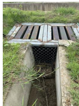
รูปที่ 6 ระบบระบายน้ำฝนโรงงาน
