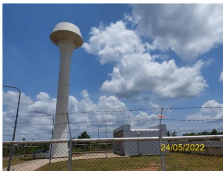
รูปที่ 15 หอถังสูงขนาด 250 ลูกบาศก์เมตร
