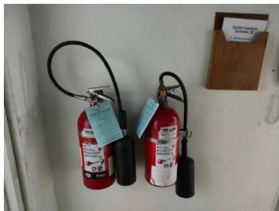
รูปที่ 2-25 ถังดับเพลิงชนิดมือถือและคำแนะนำการใช้
