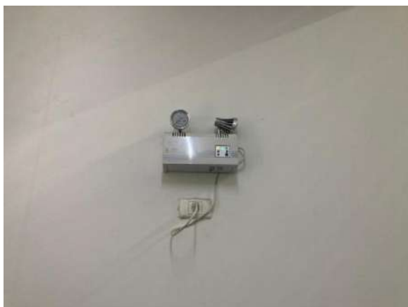
รูปที่ 2-18 ระบบไฟฉุกเฉิน
