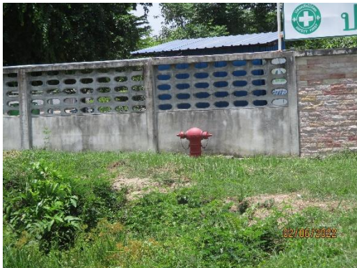
รูปที่ 17 หัวจ่ายน้ำดับเพลิงของนิคมฯ
