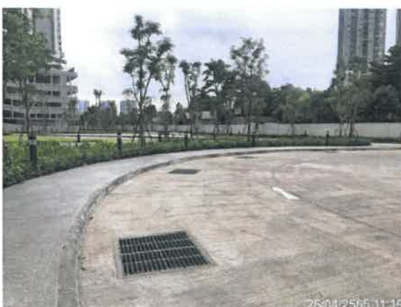
รูปที่ 2-12 แสดงท่อระบายน้ำรอบพื้นที่ก่อสร้าง
