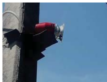
รูปที่ 2-5: หอสัญญาณเตือนการระเบิด
