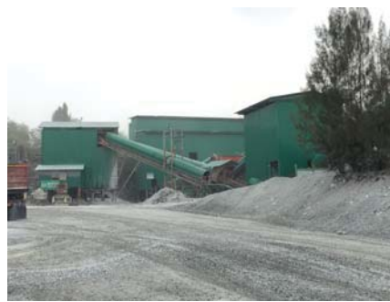
รูปที่ 2-21: การปิดคลุมอาคารโรงโม่
