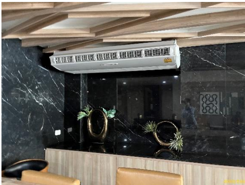
ระบบปรับอากาศแยกส่วน (Split Type Air Conditioning Unit)
