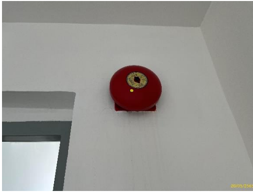
อุปกรณ์ส่งเสียงสัญญาณเพื่อแจ้งเหตุเพลิงไหม้
