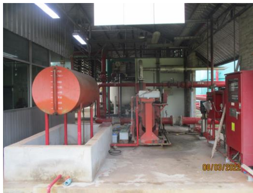
รูปที่ 40 เครื่องสูบน้ำดับเพลิง
