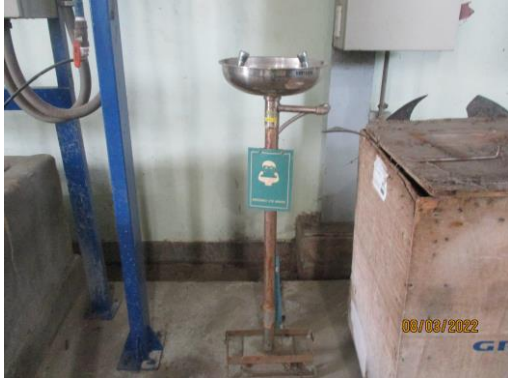
รูปที่ 31 ผักบัวฉุกเฉินและอ่างล้างตา
