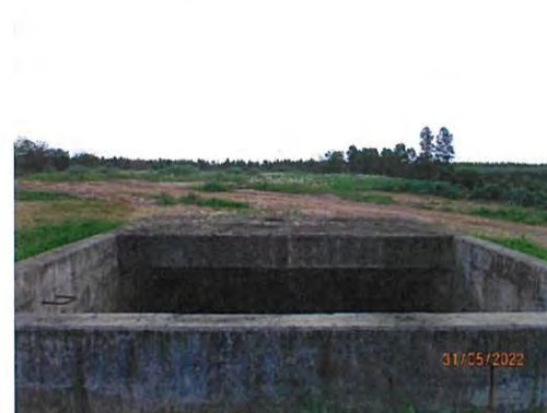
ภาพที่ 2-4 บ่อพักน้ำเสียโครงการ (Manhole)
