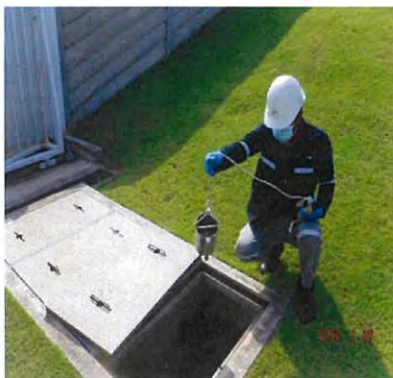
ภาพที่ 2-3 (ต่อ) บ่อตรวจสอบสภาพน้ำภายใน โรงงาน (Inspection Manhole)
