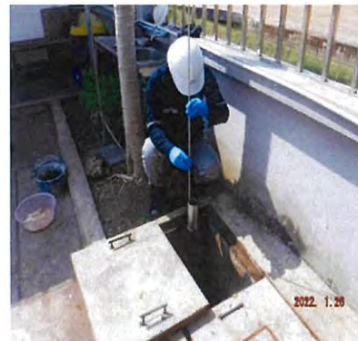
ภาพที่ 2-3 บ่อตรวจสอบสภาพน้ำภายในโรงงาน (Inspection Manhole)
