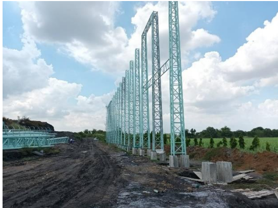
รูปที่ 36 การก่อสร้างติดตั้งเสาสำหรับติดตั้งแนวตาข่ายรอบลานกองถ้ำ
