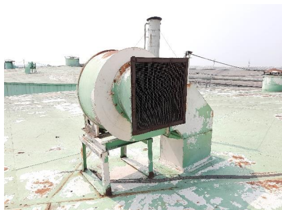
รูปที่ 99 พัดลมระบายความร้อน บริเวณถังเก็บกากน้ำตาล
