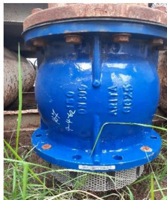
รูปที่ 55 การติดตั้งตะแกรงตาข่ายปลายท่อสูบน้ำแม่น้ำป่าสัก
