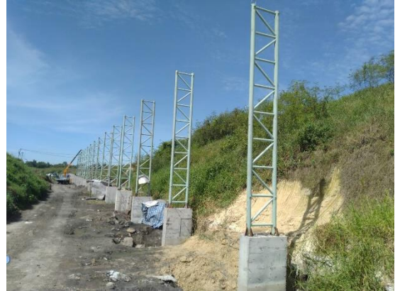
รูปที่ 30 การก่อสร้างติดตั้งเสาสำหรับติดตั้งแนวตาข่ายรอบลานกองกากตะกอนฯ
