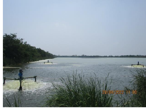
รูปที่ 48 ระบบบำบัดน้ำเสียแบบบ่อผึ่ง
