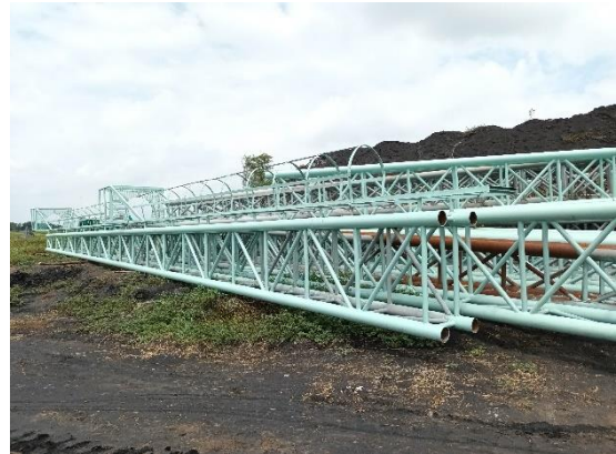
รูปที่ 36 การก่อสร้างติดตั้งเสาสำหรับติดตั้งแนวตาข่ายรอบลานกองถ้ำ
