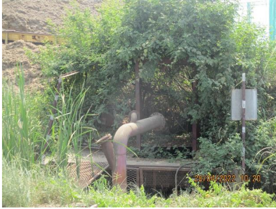
รูปที่ 19 ระบบรวบรวมน้ำชะลานกองกากอ้อย
