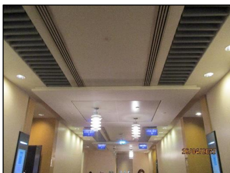
รูปที่ 2-20 การติดตั้งระบบแสงสว่างภายในอาคารไม่สูงกว่า 16 วัดต่อตารางเมตร
