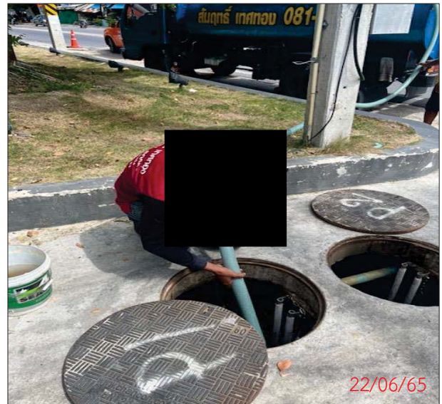
สูบน้ำจากบ่อเก็บตะกอนภายในโครงการ
