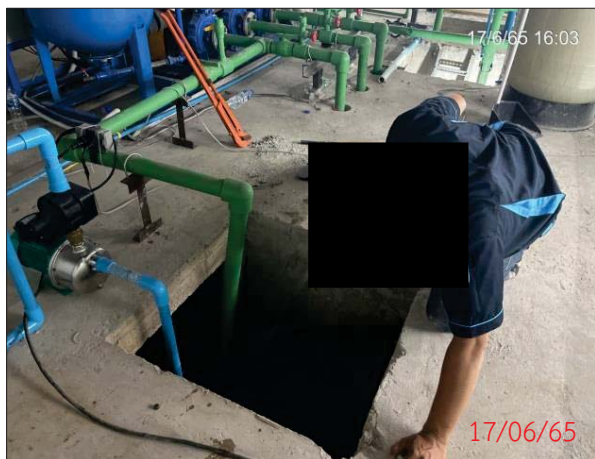
ถังสำรองน้ำใช้ใต้ดินของโครงการ
